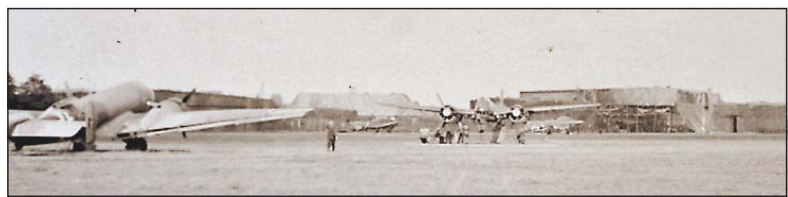
Eindeutig zeigt dieses Bild den Fliegerhorst Gütersloh, denn die im Hintergrund zu sehenden Wartungshallen gibt es noch heute.
